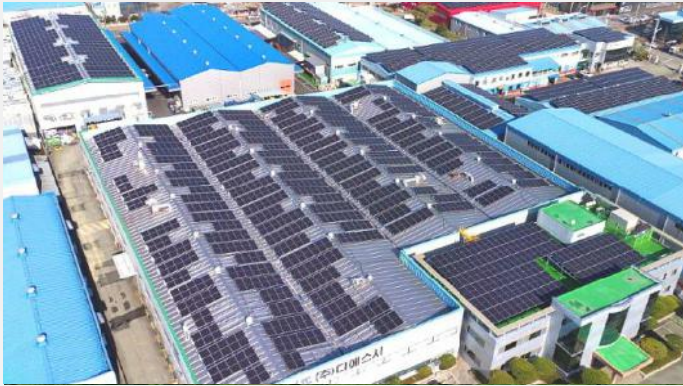
DSC 광주공장 태양광발전소 (광주광역시)
