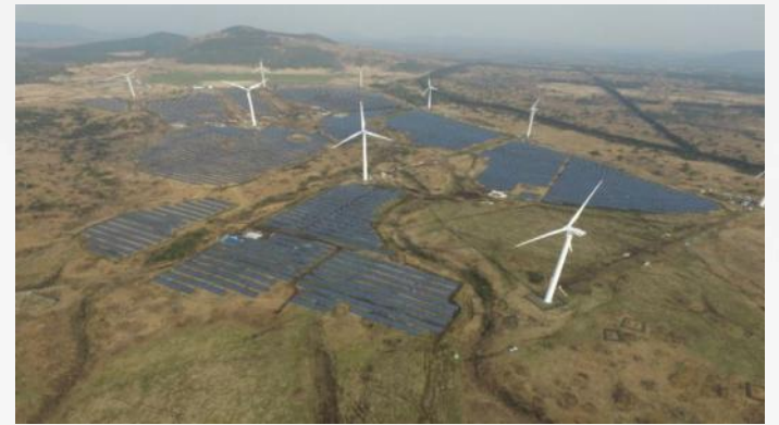
가시리 태양광발전소 (제주도 서귀포)
